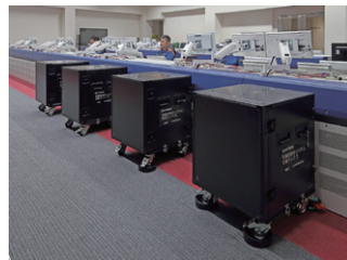
通常使用時の状況
